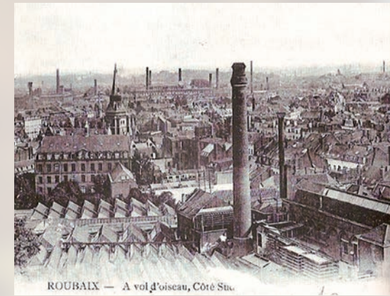
Cheminées des usines textiles de Roubaix, © archives municipales de Roubaix
